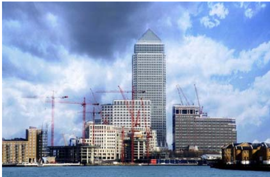
Abbildung 21: Canary Wharf im Bau
