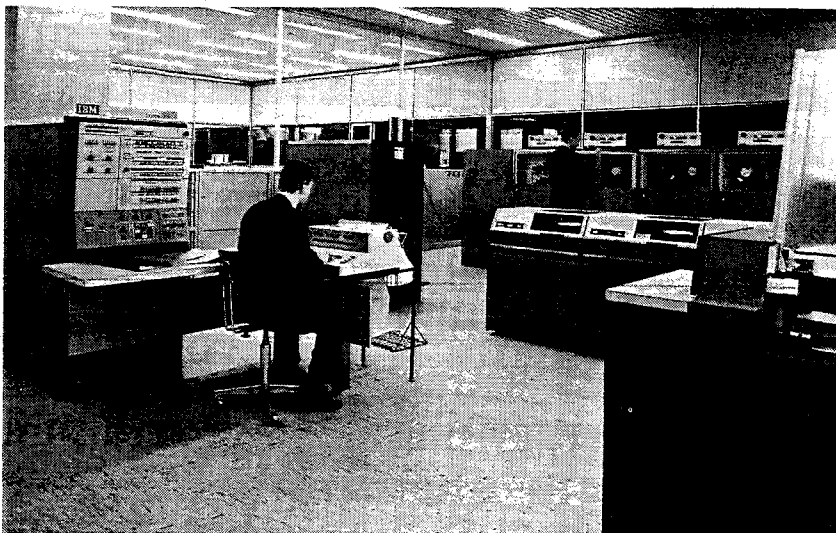
Bild 11: IBM-Großrechenzentrum Düsseldorf. Zu den hier installierten Computern gehört u. a. ein IBM System/360 Modell 40. Links im Bild die Zentraleinheit mit Steuerpult und Konsol-Schreibmaschine, rechts Plattenspeicher, im Hintergrund Magnetbandeinheiten.
