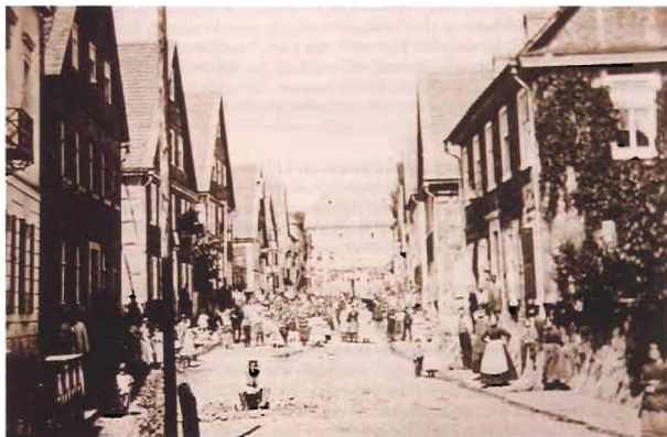
Nach dem Großbrand Richtfest der wieder aufgebauten Buchdruckerei Weigel am 27./28. Juni 1854
