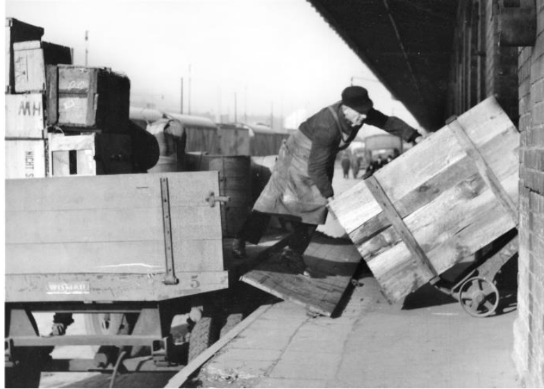
Abbildung 6: Umständlicher Umschlag von Stückgut mit der Sackkarre an der Laderampe an einem Berliner Bahnhof 1938. Man beachte die Beschädigung der Rampe im Vordergrund. 39 (Foto Reichsverkehrsministerium, freigegeben von der Eisenbahnstiftung Joachim Schmidt)
