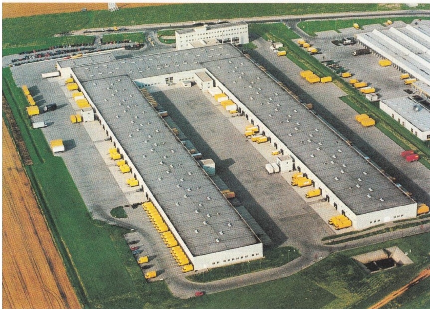
Abbildung 23: Das U-förmige Layout der Pakethalle der Frachtpost in Radefeld bei Leipzig im Jahre 1995. (Quelle: Post- und Telekommunikationsgeschichte, Region Ost, Heft 1, 1997, S. 21, freigegeben vom Archiv der Post)
