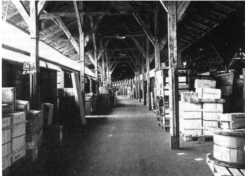
Abbildung 7: Feststeckende Stückgüter in der Umschlagshalle von Bietigheim 1972.
