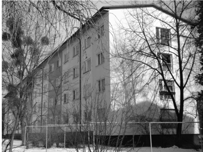
Abb. 97: Vollständig modernisiertes Gebäude in Hoyerswerda
