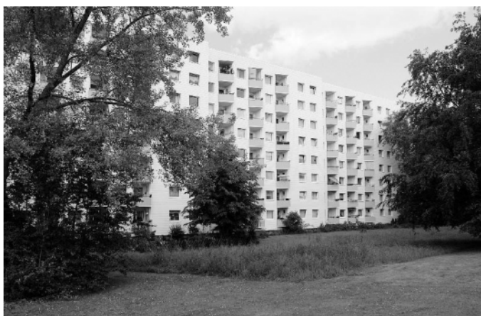
Abb. 106: Teilmodernisiertes Gebäude in Bremen, Bildquelle: GEWOBA
